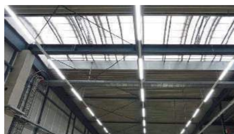
Ein Oberlichtband sorgt für natürliches Licht, um den Energiebedarf für Beleuchtung zu reduzieren.
