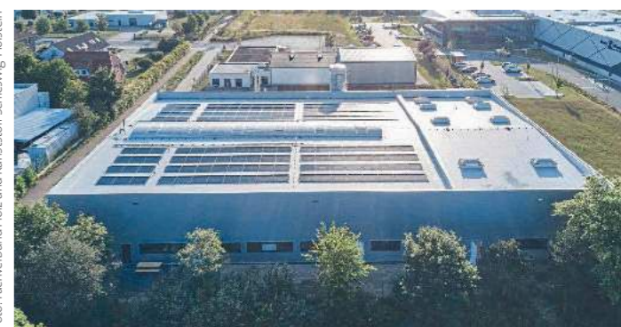
! Praxisbeispiel der Tischlerei Michael Biesel: Die Photovoltaikanlage versorgt eine Luftwärmepumpe für die Hallenheizung mittels Betonkernaktivierung.
