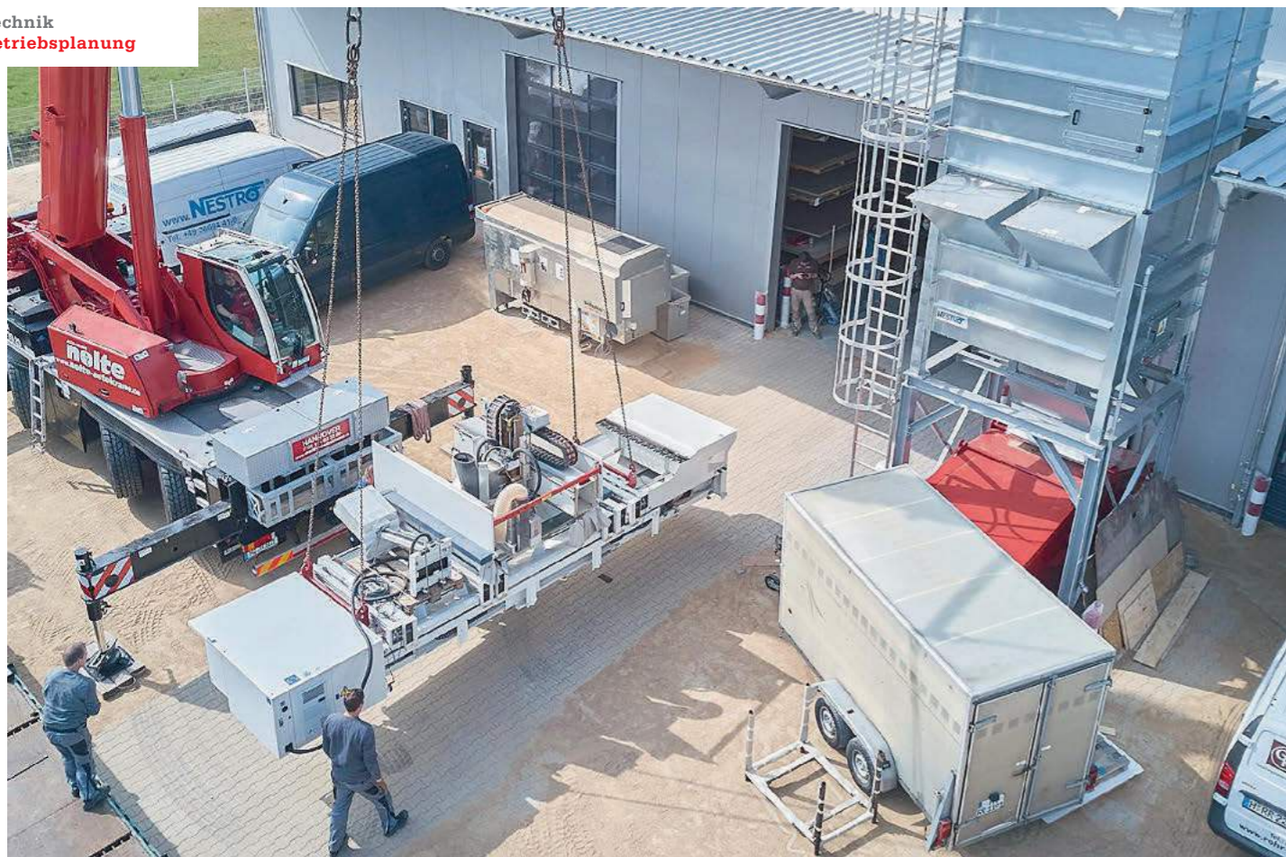
! Eine neue energie- und ressourceneffiziente Tischlerei entsteht: Industriehallenbau in KfW 55 Standard lässt nur wenig Wärme entweichen. Sowohl die stückigen Holzreste als auch Staub und Späne gehen an Egger zur stofflichen Wiederverwertung zurück.
