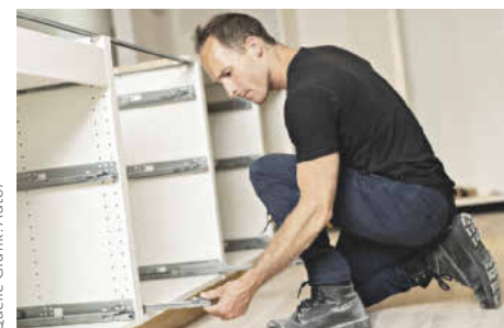
/ Bei Projekten kommt es immer auf die zeitliche Planung an. Das gilt natürlich auch für die Baustellenorganisation und Montagetätigkeiten.
