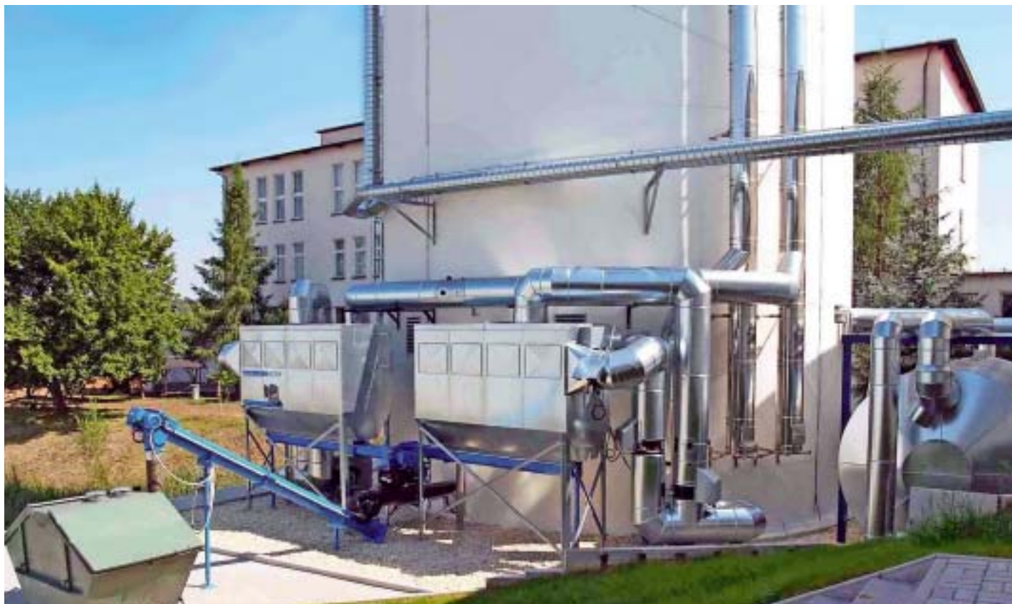
/ Rauchgas-Kunststoffgewebefilter für die Außenaufstellung (Nestro Lufttechnik)
