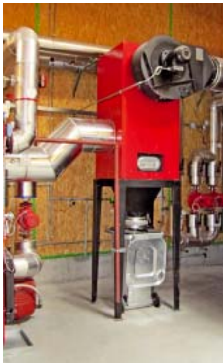
/ Multizyklon zum Abscheiden grober Staub- und Rußpartikel (WVT-Bioflamm, Overath)
