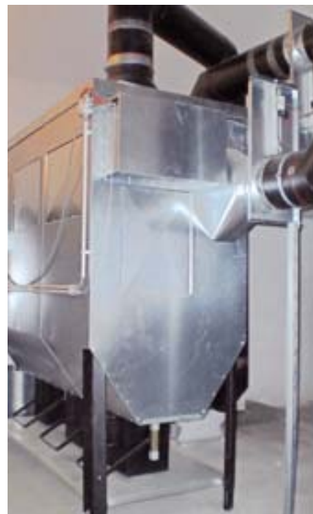
/ Rauchgas-Kunststoffgewebefilter für die Innen- aufstellung (Nestro Lufttechnik)
